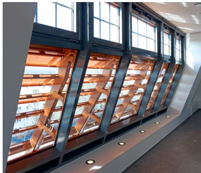
Heinrich-Mann-Allee 102, Ministerium der Justiz, Potsdamer Landtagsgelände: Lamellenkonstruktion von innen
