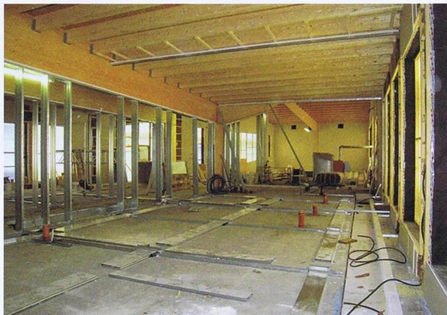
**Bild 8** Aufbau der Fußbodenkanäle auf Bodenplatte
