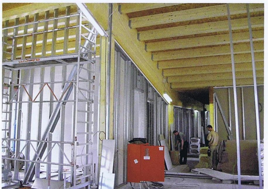
**Bild 7** Trockenbauwände im Innenraum
