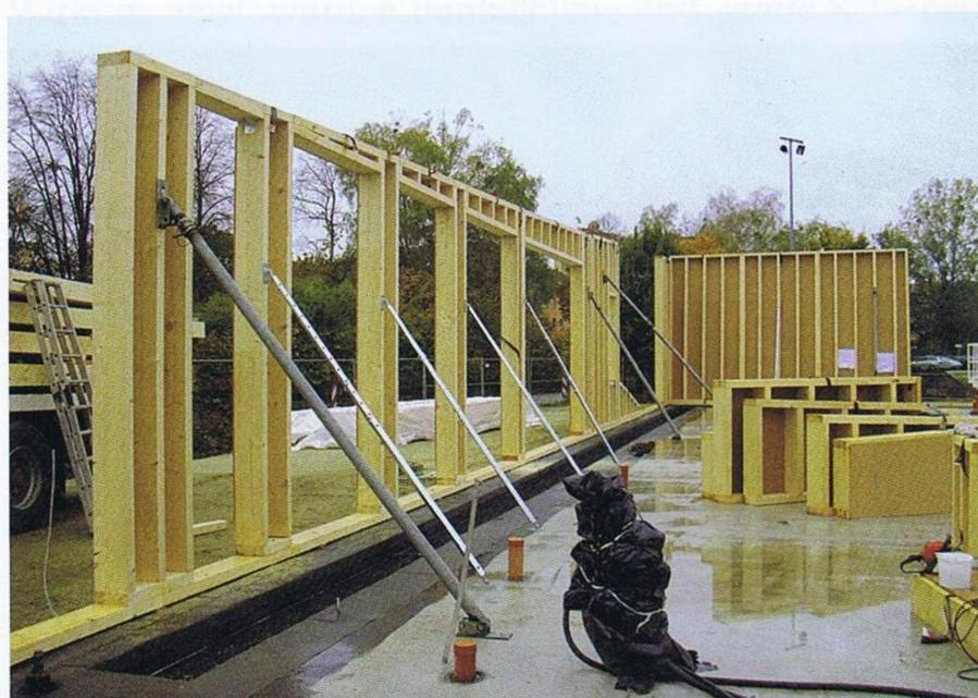
**Bild 2** Beginn Aufbau Holzständerkonstruktion
