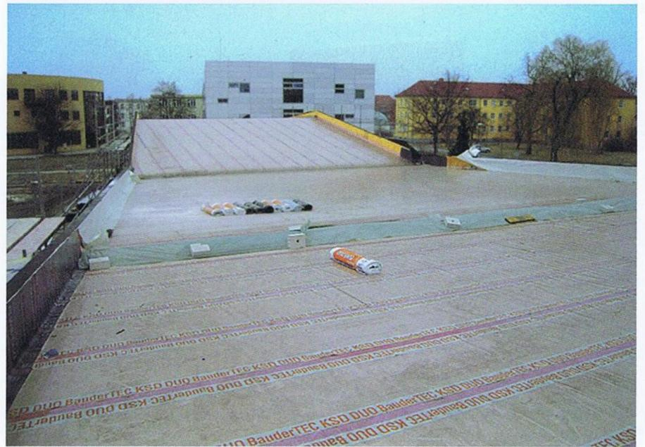
**Bild 6** Abdichtungsbahnen auf dem Faltdach
