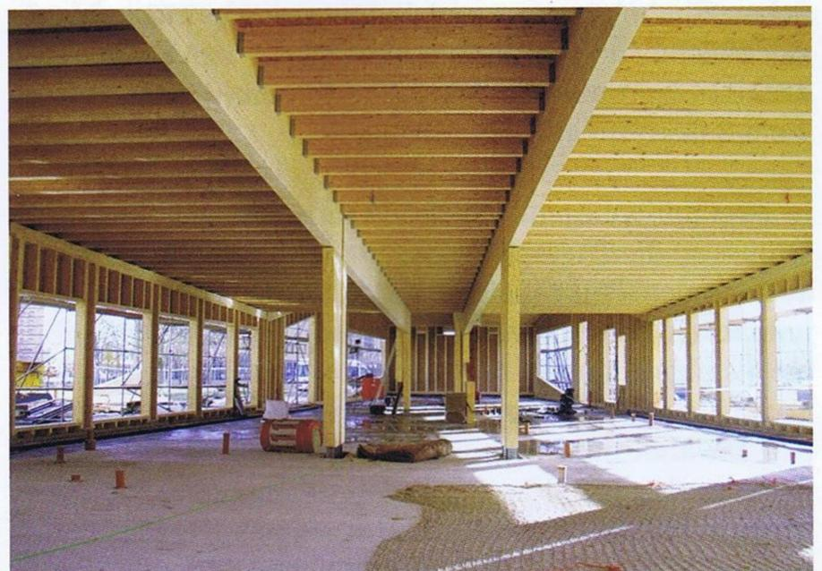
**Bild 3** Fertig errichtete Tragkonstruktion mit Leimbinder
