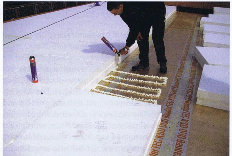
**Bild 5** Wärmedämmung des Dachs wird direkt auf die Abdichtungsbahnen geklebt
